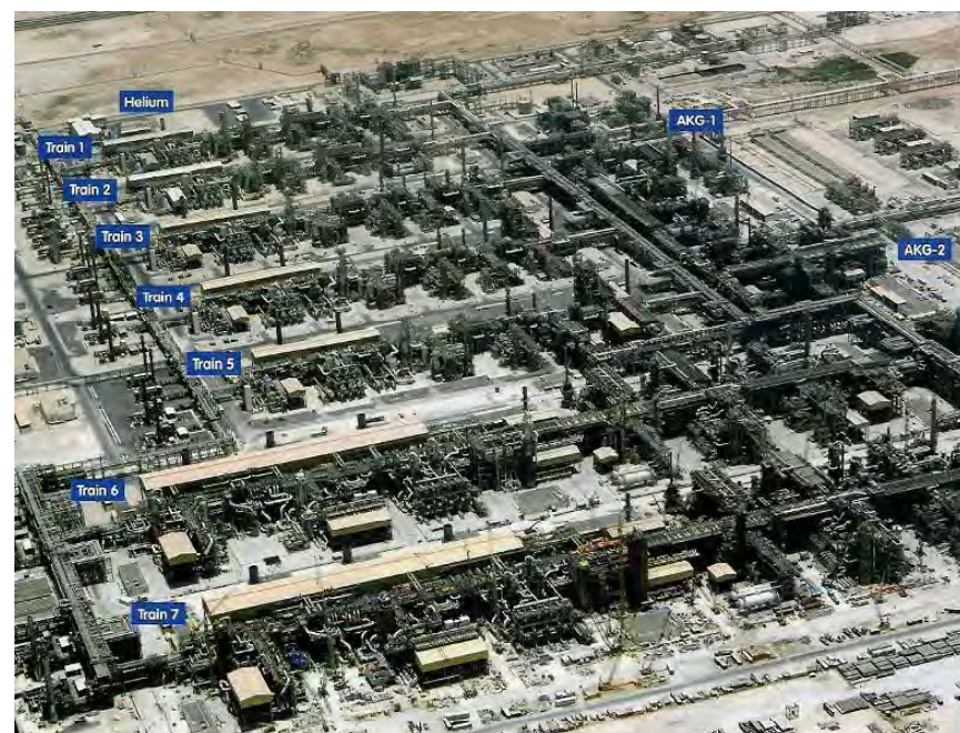
UCARSOL™ and SELEXOL™ Solvents in 5 World Scale LNG Plants in Ras Laffan, Qatar
